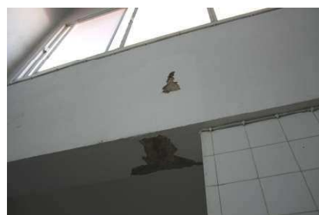
Catas en viga de atado
