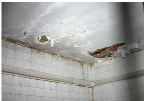
Estado del techo previo a la apertura de catas.
