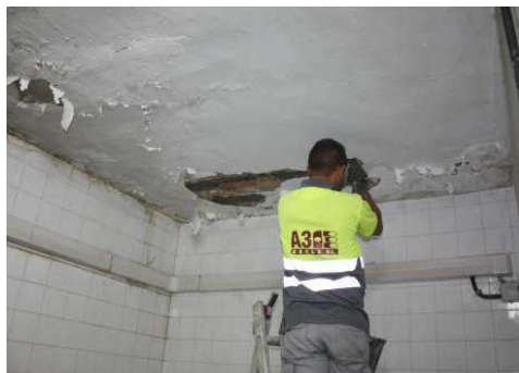
Forjado de techo de zona A
