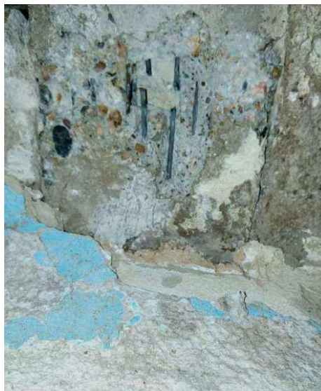
Armado inferior de vigueta en cabeza
