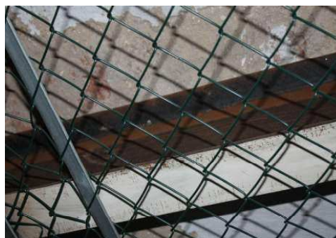
Refuerzo de forjado. IPN 180
