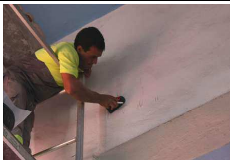
Detección de armaduras
