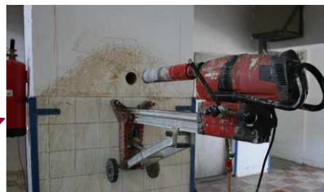
Pilar en planta baja. (Tramo 1)
