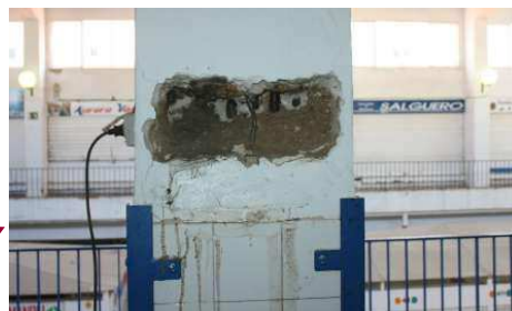
Pilar en planta primera. (Tramo 2)
