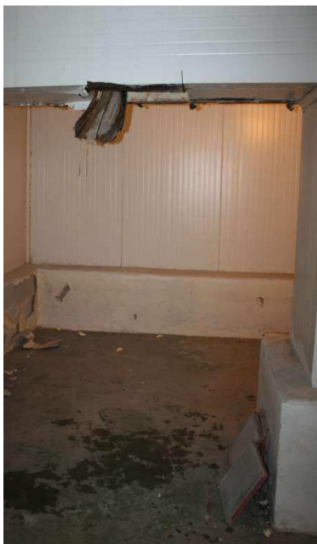
Estado del techo previo a la apertura de catas.
