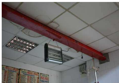
Refuerzo de viga. HEB 200
