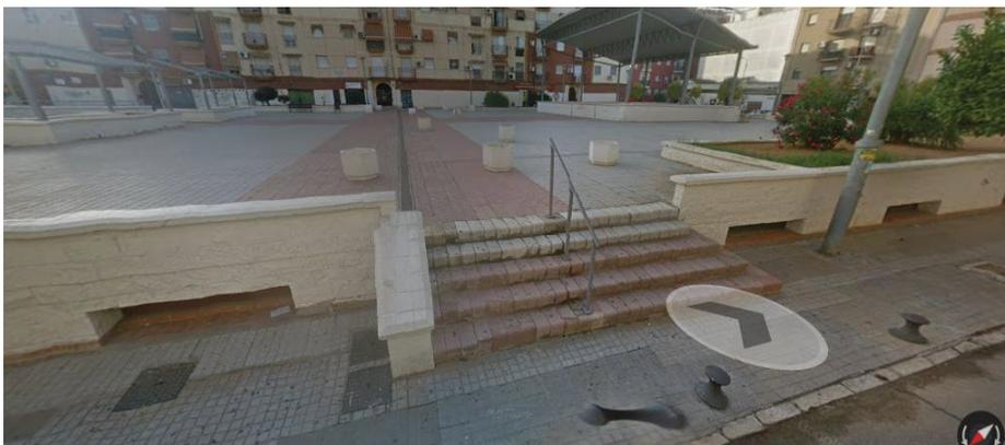
Las escaleras de conexión con la plaza se mejoran sustancialmente con un revestido de granito y se colocará una barandilla de acero inoxidable.
