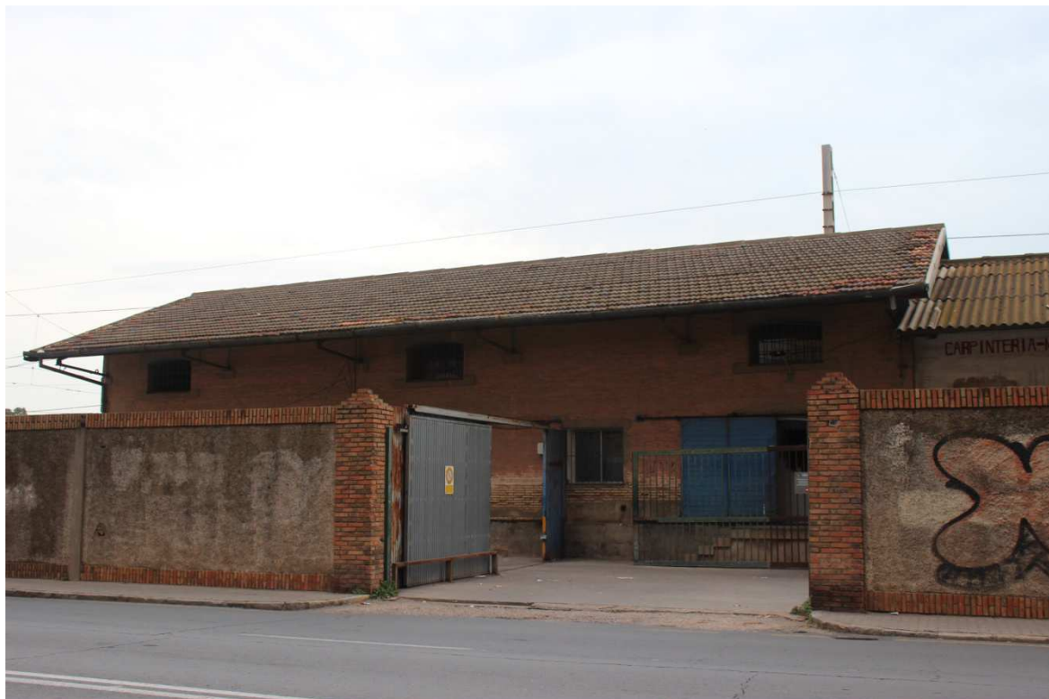
IM.13 e IM.14. Nave ferroviaria a valorar su rehabilitación como dotación pública en parque.
