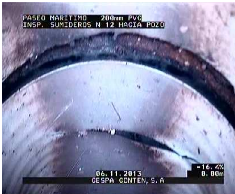
Inspección sumidero n° 12
