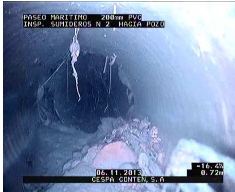
Inspección sumidero n° 2
