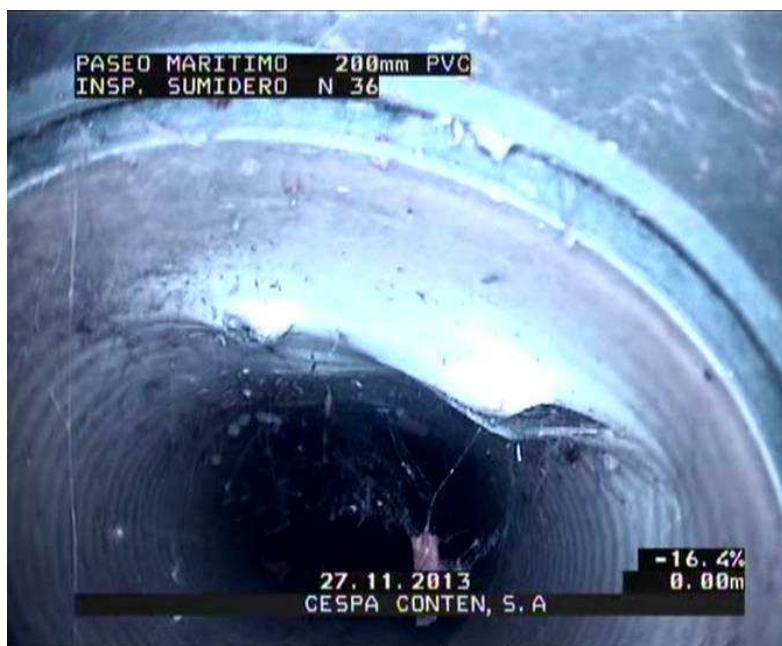
Inspección sumidero n° 36
