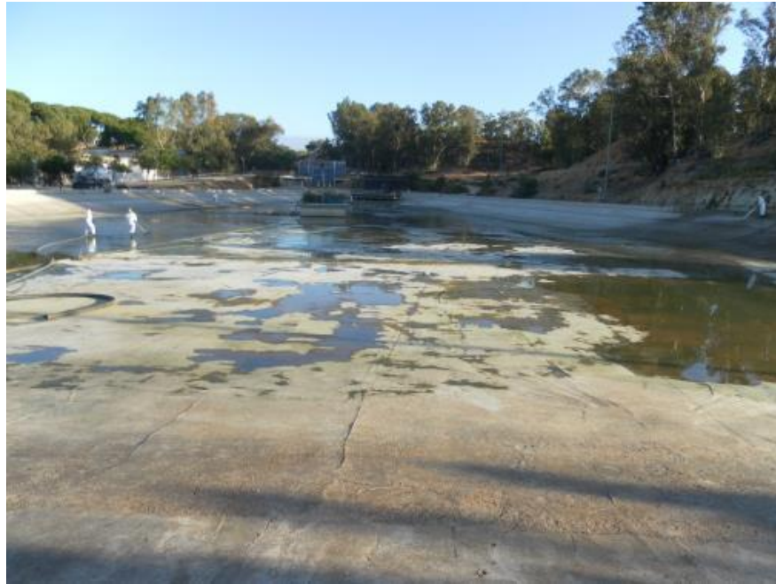
Limpieza de estanques de Parque Moret
