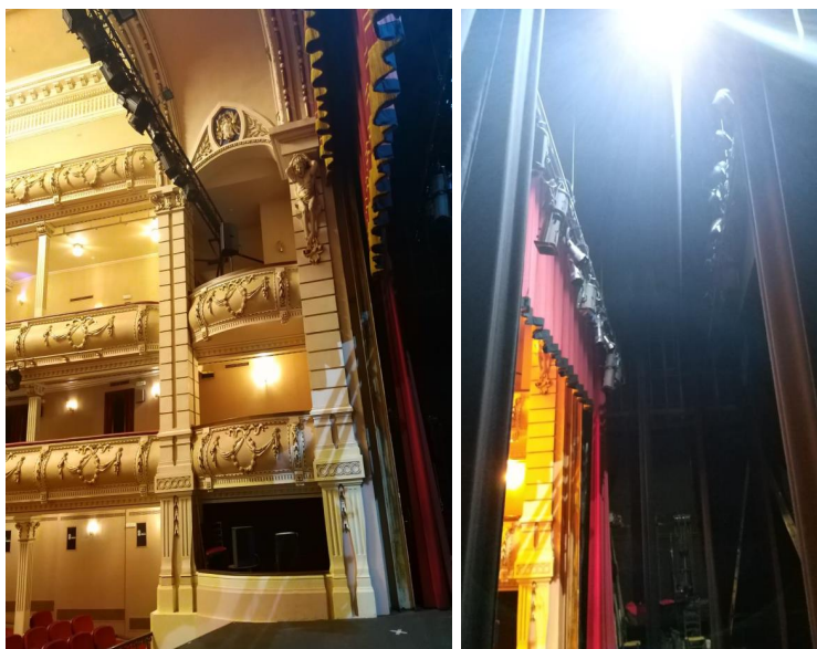
Estructura puente existente y salida a escenario // Falso techo existente, paso de tensores para nueva estructura
