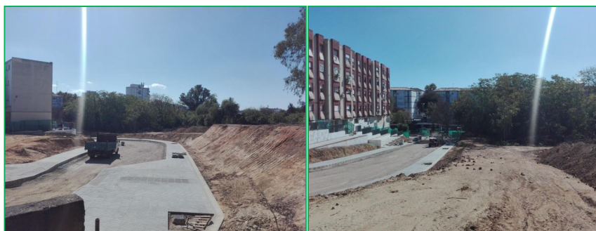
Ejecución de las obras (actualmente finalizadas). Estado de los márgenes a tratar
