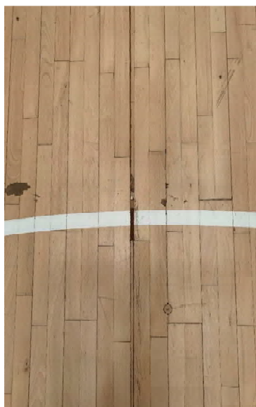
Fotografías donde podemos observar el mal estado del pavimento, con juntas abiertas y levantadas.
