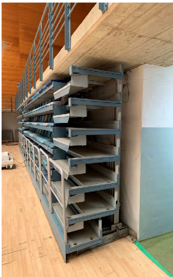
Fotografía del graderío telescópico plegado, recogido bajo el vuelo de la pasarela de planta baja.
