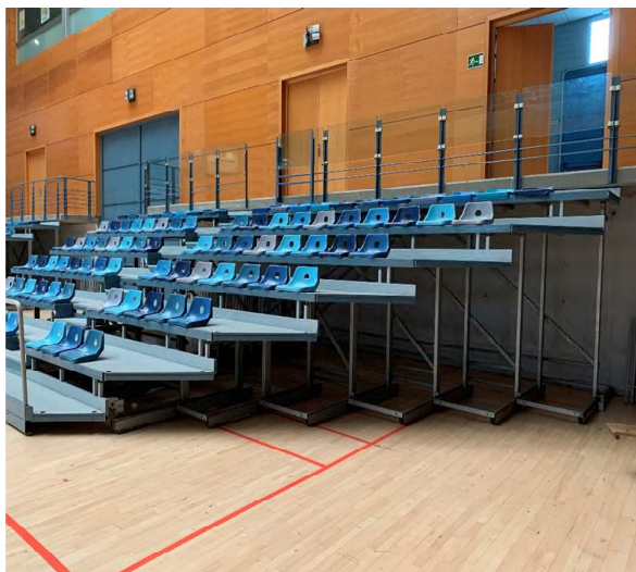
Fotografía del graderío telescópico desplegado
