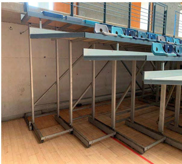
Fotografía donde se muestra el rodapié metálico que tapa la junta de dilatación del pavimento junto a la pared perimetral justo debajo del graderío telescópico. Que en este caso está desplegado.
