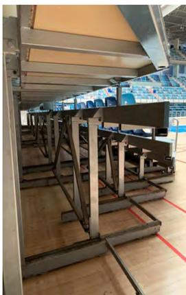
Fotografía que se muestra la estructura metálica del graderío telescópico.
