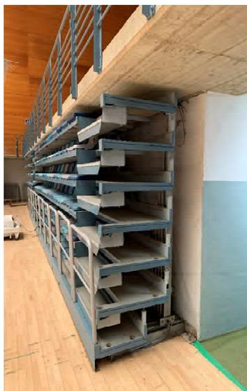
Fotografías donde podemos observar las gradas telescópicas desplegadas y recogidas.
