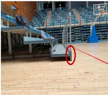
*Perfil que hay que cortar para que no roce con el suelo y pueda absorber el desnivel del pavimento sin dañarlo cuando se despliegan las gradas*
