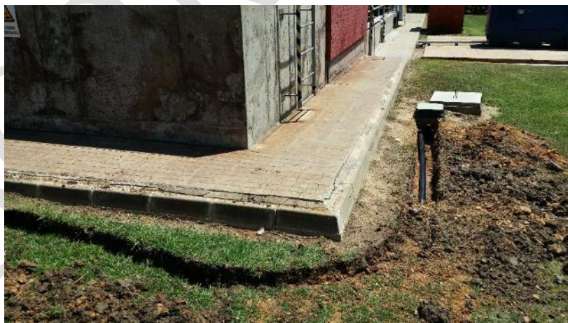
Nueva conducción de Agua de Servicio para Riego
