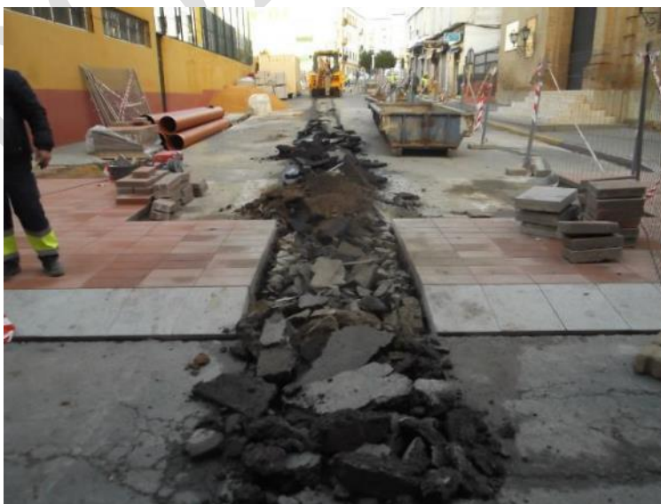
Vista general del comienzo de las obras
