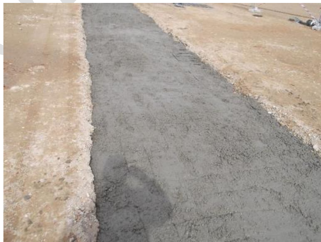
Ejecución de la losa de protección.
