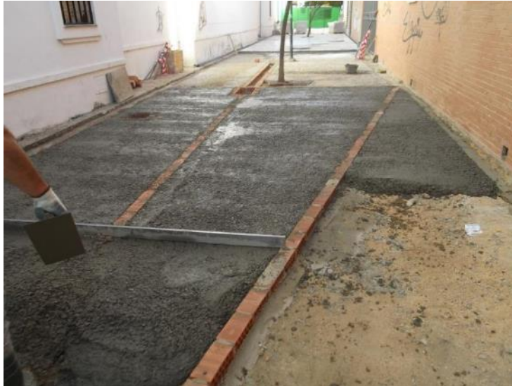
Ejecución de la obra
