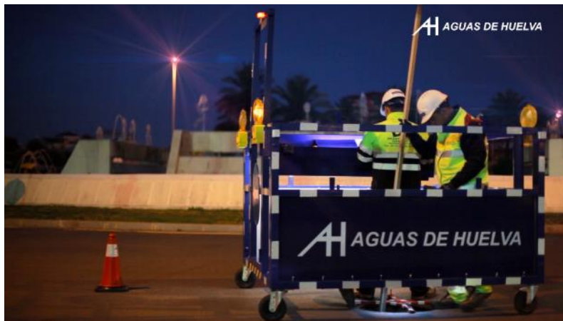
Estructura diseñada para la toma de datos en campo, especialmente zonas de viario público.
