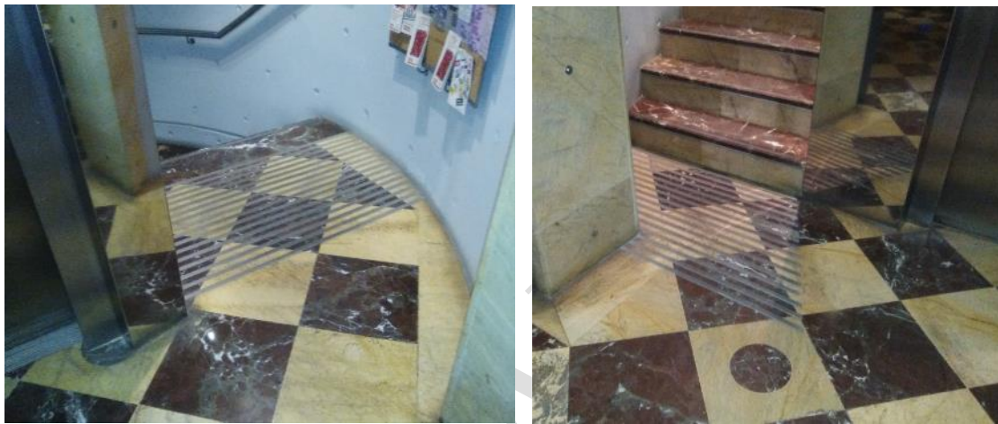
Señalización accesible para invidente
