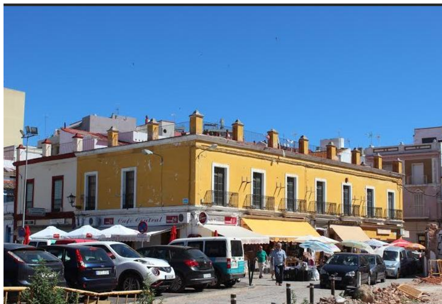
Café Central. Su mantenimiento podría ser deseable previa inserción en ordenación adecuada; decisión que es objeto de ordenación pormenorizada del PERI.
