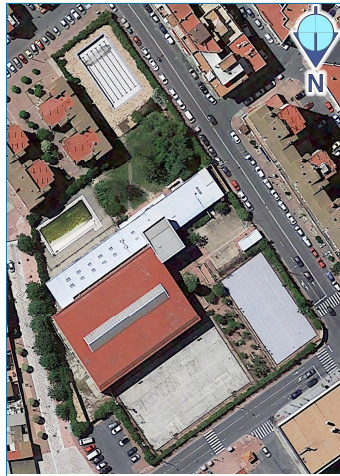
foto aérea de la situación de las edificaciones y construcciones (11/06/2016)
