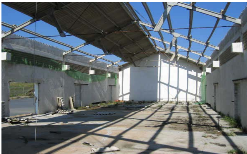
ESTADO INICIAL VISTA INTERIOR NAVE 1
