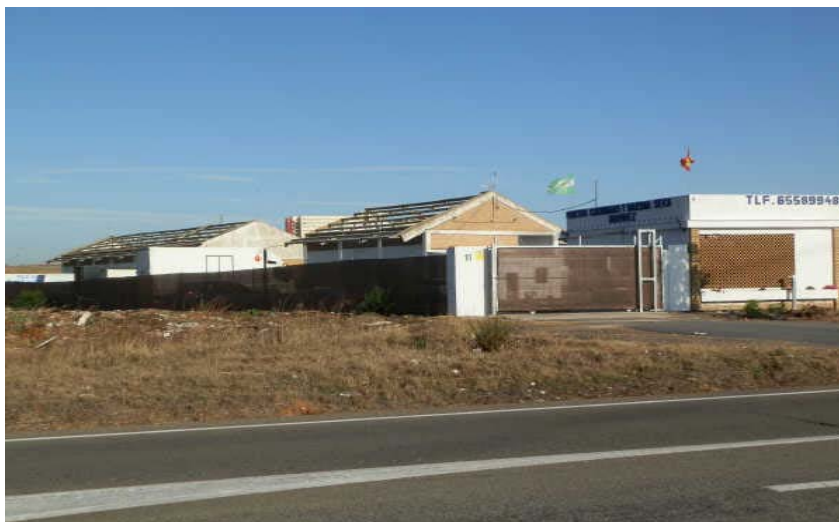
ESTADO ACTUAL. VISTA LATERAL OFICINA, NAVE 1 Y NAVE 2
