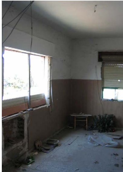
ESTADO INICIAL VISTA INTERIOR OFICINA
