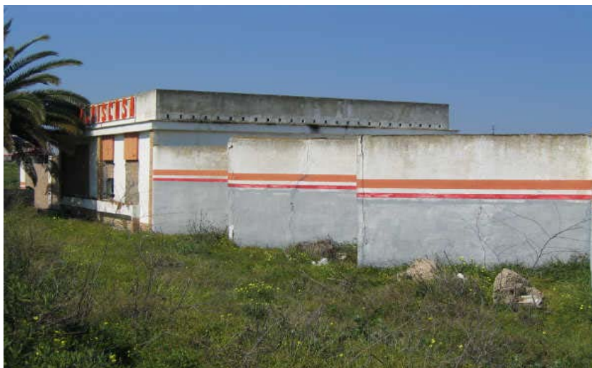
ESTADO INICIAL. VISTA DESDE EXTERIOR, OFICINA Y EDIFICACIÓN EN RUINAS
