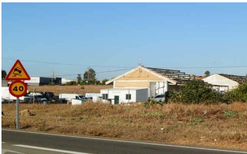
ESTADO ACTUAL. VISTA NAVE 2 Y NAVE 1
