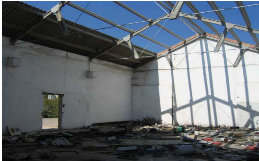
ESTADO INICIAL VISTA INTERIOR NAVE 2
