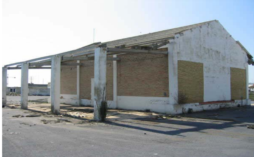
ESTADO INICIAL VISTA NAVE 2
