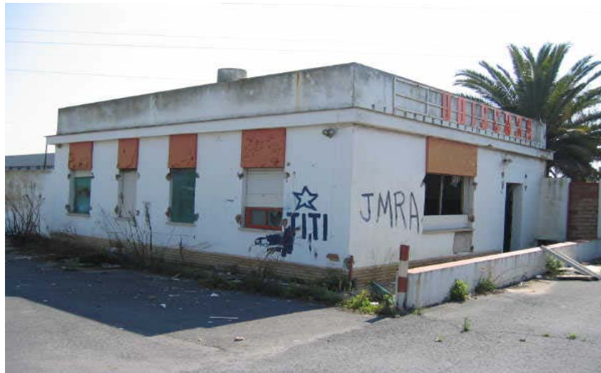
ESTADO INICIAL VISTA OFICINA
