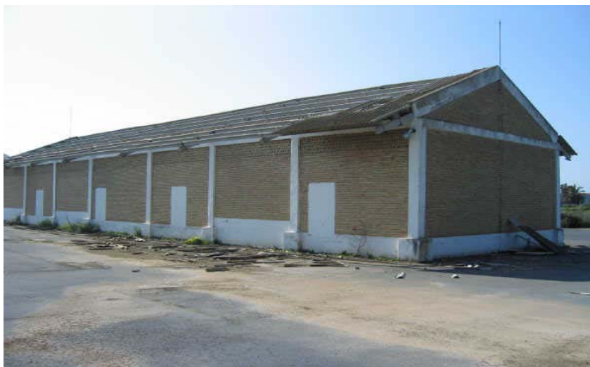
ESTADO INICIAL VISTA NAVE 1
