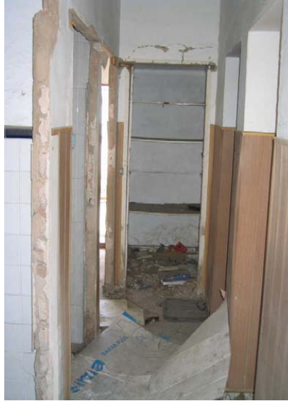
ESTADO INICIAL VISTA INTERIOR OFICINA
