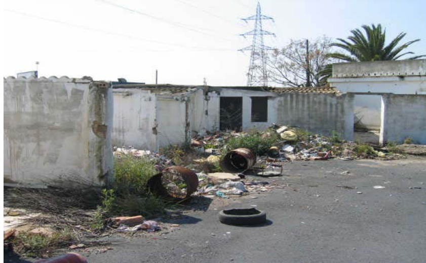
ESTADO INICIAL VISTA EDIFICACIÓN EN RUINAS
