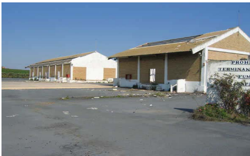
ESTADO INICIAL VISTA GENERAL NAVES
