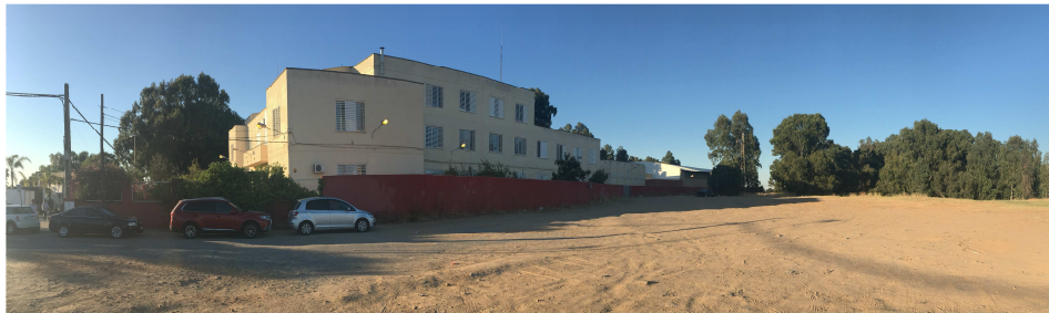
Imagen del edificio actual y zona donde se ubicará la ampliación.
