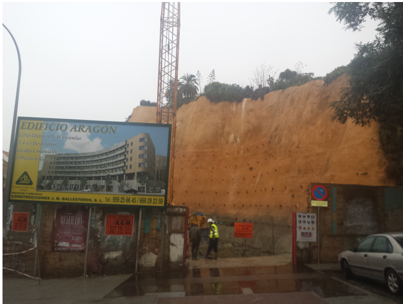
Obras en ladera del Cabezo de San Pedro – C/ Aragón equina a Plaza de la Piterilla
