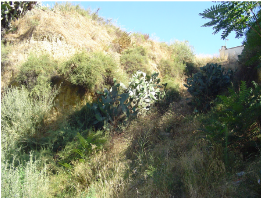
Foto 2. Cabezo Mondaca, Calle Ramón Menéndez Pidal, en la parcela 03, donde se prevé realizar una construcción, por lo que habrá de realizar un desmante en buena parte de la vista que se muestra.
