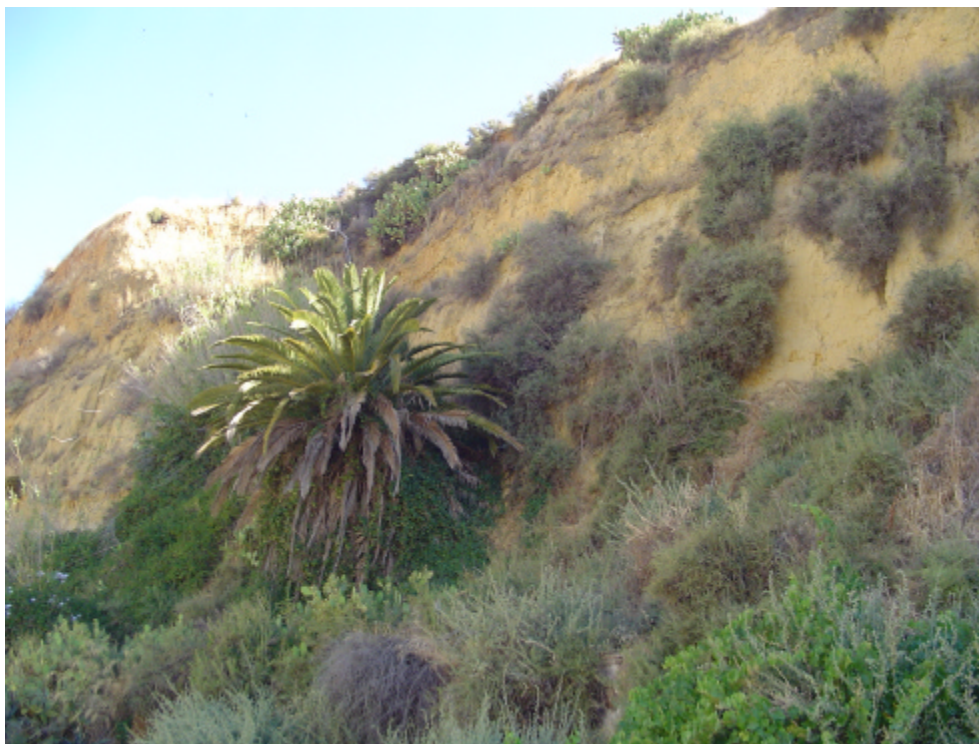
Foto 5. Vista parcial del talud comentado en la F4.
