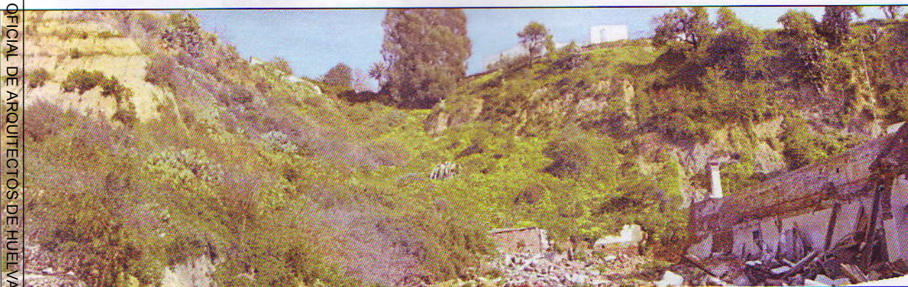
Foto. 11 – Panorámica del talud.
