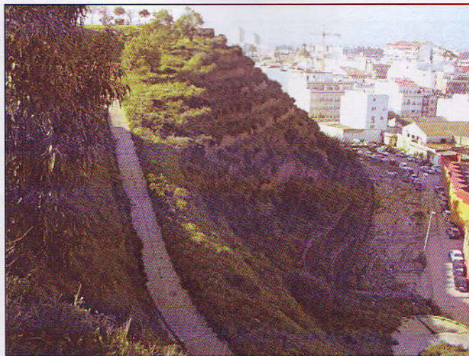
Foto. 15 – Vista del Talud D.
