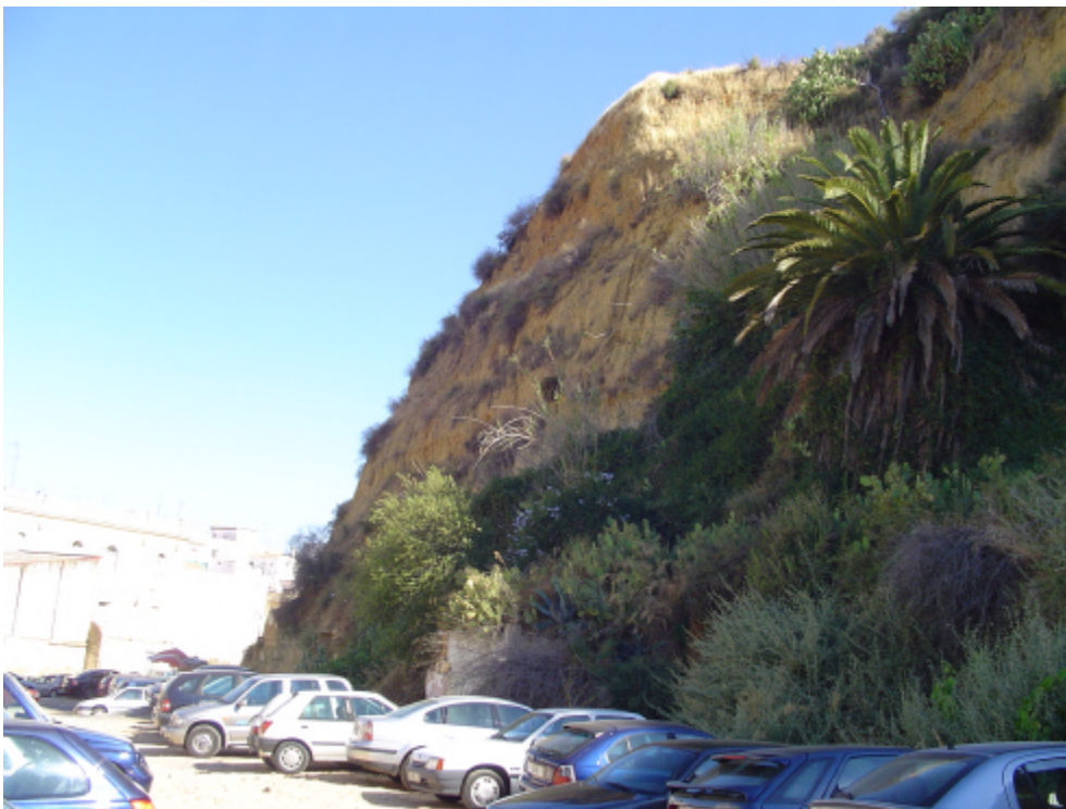
Foto 4. Talud de 29 metros en el Cabezo Mondaca en la esquina entre las calles Menéndez Pidal y Luis Buendía. El talud se encuentra muy verticalizado, por lo que hay riesgo de desprendimiento.
