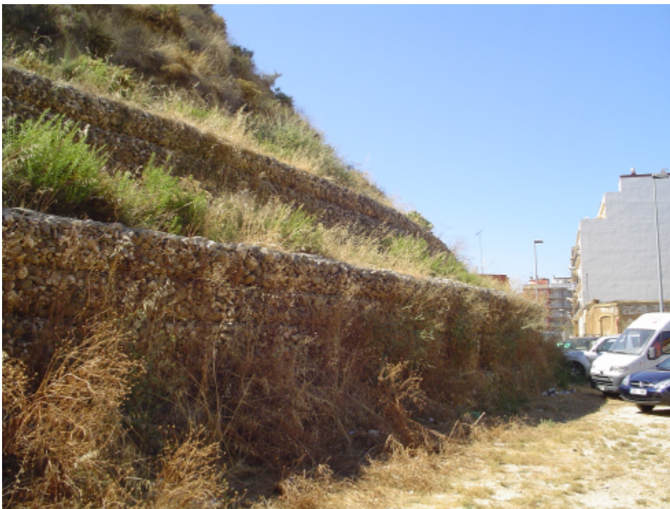
Foto 17. Muro de gaviones comentado en la foto F16.
