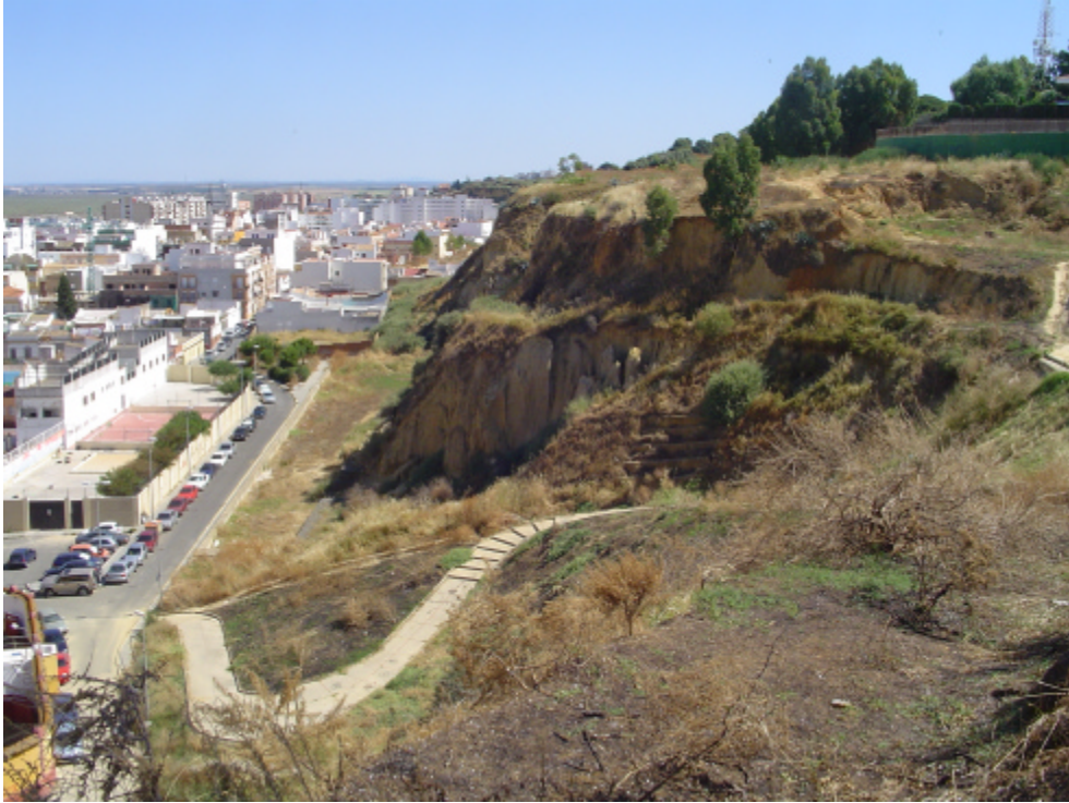
Foto 21. Vista más general del camino y talud comentados en las fotos F19 y F20.
