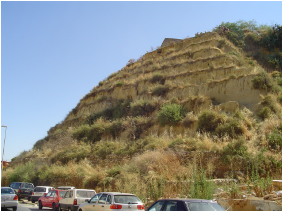
Foto 15. Vista más cercana del talud comentado en la foto F14. Nuevamente se observan vehículos aparcados al pie del talud lo cual supone un riesgo importante, dada la verticalización que presenta en este punto.
