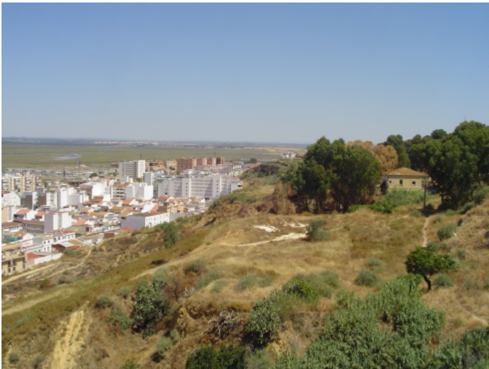
Foto 24. Aspecto del Cabezo del Conquero hacia el Norte. Barriada de las Colonias (parte inferior). En esta zona los taludes no son tan verticalizados.
