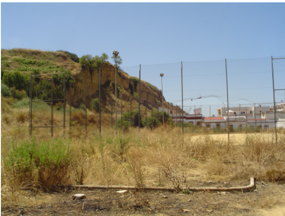
Foto 26. Parte inferior del talud comentado en las fotos F24 y F25.
