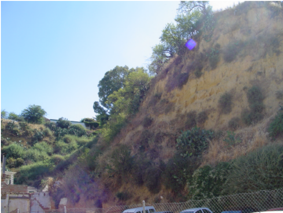
Foto 15. Vista más cercana del talud comentado en la foto F14. Nuevamente se observan vehículos aparcados al pie del talud lo cual supone un riesgo importante, dada la verticalización que presenta en este punto.
