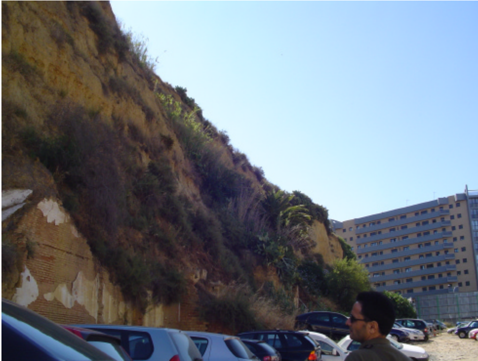
Foto 7. Talud en el Cabezo Mondaca en la esquina entre las calles Menéndez Pidal y Luis Buendía. Podemos ver los muros de antiguas edificaciones adosados al pie del talud del cabezo.
