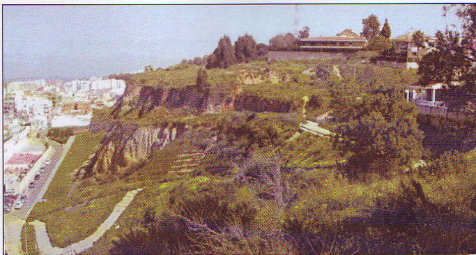
Foto. 19 – Panorámica del tramo E.
