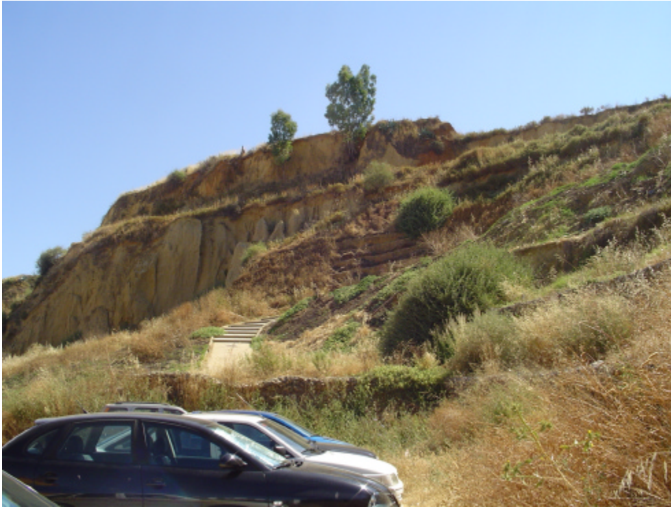
Foto 19. Cabezó Mondaca en la calle Pérez Galdós, a espaldas de la Plaza de Toros. Se ve el camino que sube a la parte superior del cabezo, a la calle Los Romeros. Al fondo se observa un talud más verticalizado, formado por arenas y limos. Se observa cierto deterioro del talud debido a erosión.
