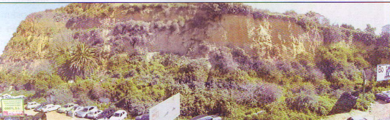
Foto. 1 – Panorámica del Talud.
