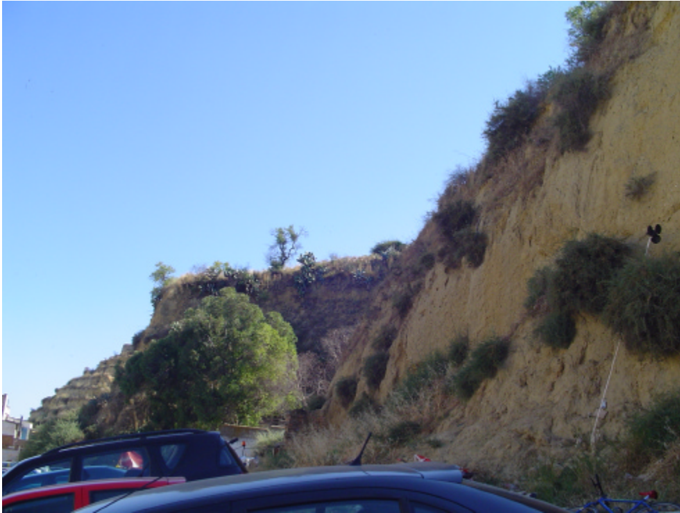
Foto 9. Prolongación del talud anterior hacia el Norte, calle Luis Buendía. Esta es una zona de aparcamiento habitual en la ciudad de Huelva, sin embargo, este es un punto crítico de los cabezos visitados puesto que probablemente se trata del que mayor riesgo de inestabilidad presenta.
