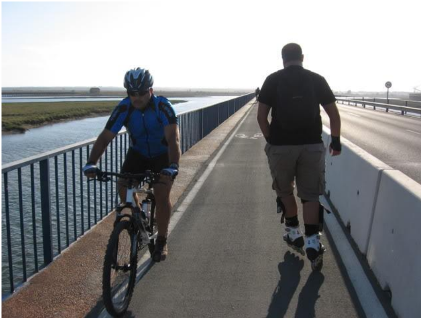
Carril-bici en el Puente Sifón sobre el río Odiel
