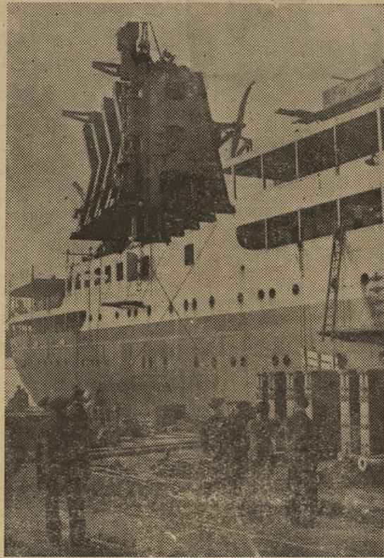
Interesante fotografía tomada en un astillero inglés en el momento que una gigantesca grúa levanta parte de la máquina de un buque en construcción--145.000 kilos--para colocarla dentro del mismo.
